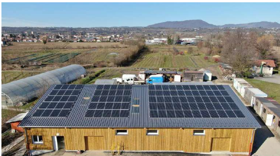
Les panneaux solaires sur le toit du bâtiment des Nouveaux Jardins de la Solidarité.
