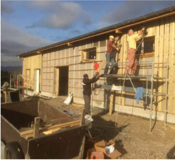
Mise en place du bardage extérieur par les bénévoles
