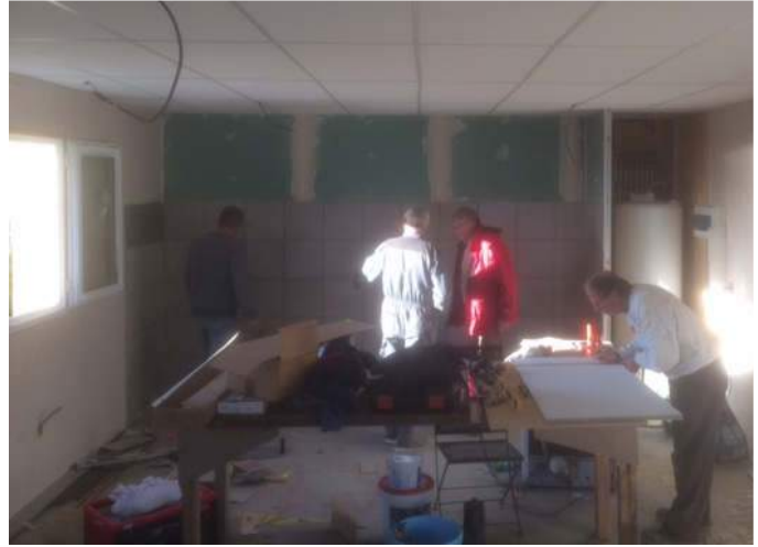
Isolation et aménagement de la future salle de pause/ cuisine
