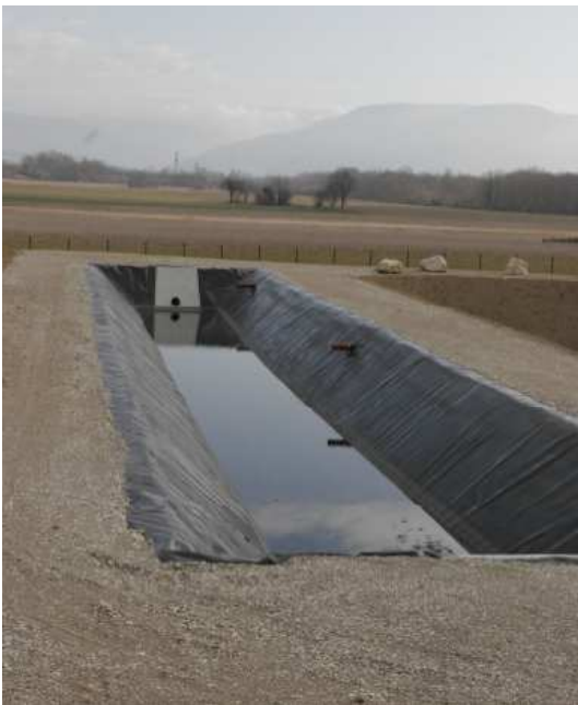
Bassin de décantation
